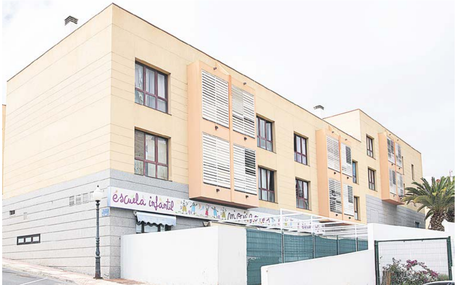
Edificio Centenario de Morro Jable. Foto: Carlos de Saá.
