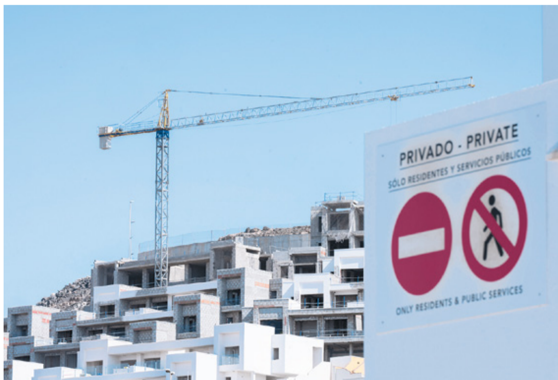
Urbanización en construcción.
