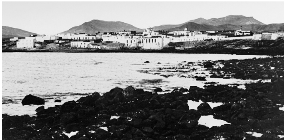
Imagen en la que se aprecian los almacenes que fueron demolidos para la ejecución del proyecto. Autor: Anónimo (Propiedad de la autora).
