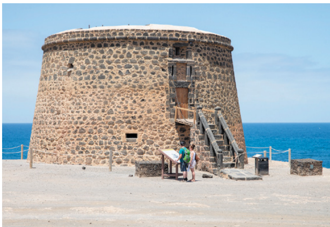
Torre del Tostón. Foto: Carlos de Saá.
