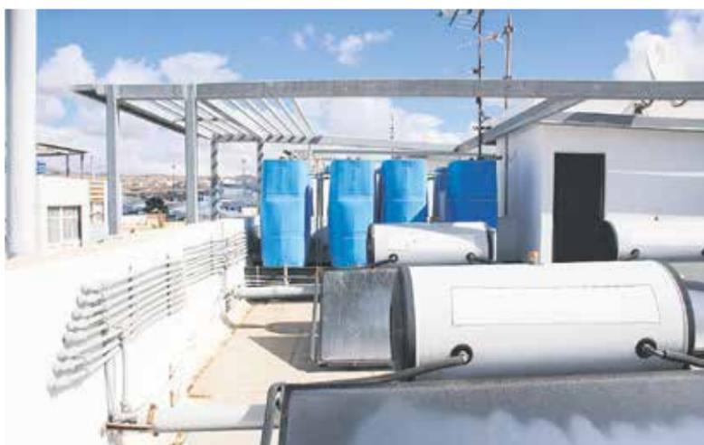
La cubierta presenta deficiencias en las canalizaciones que provocan filtraciones y las placas solares están deterioradas.
